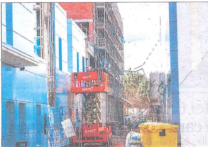
Edificio en obras donde se instalará el servicio de farmacia ya modernizado. MONTESEGUROFOTO
